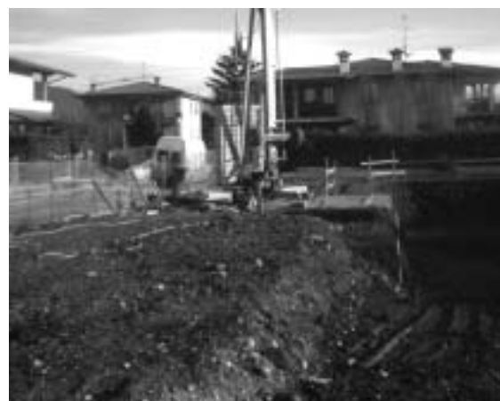
▲ Attenzione alla consistenza della parete dello scavo
